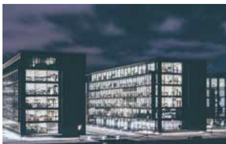
Éclairage des bureaux et des environnements de travail
